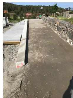
Varmekabler blir lagt i rullestolrampe.
