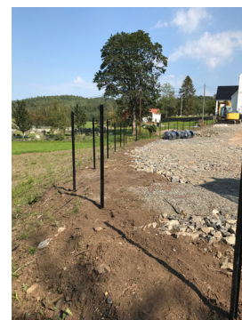
Nye gjerder blir satt opp rundt store deler av gravplassen.
